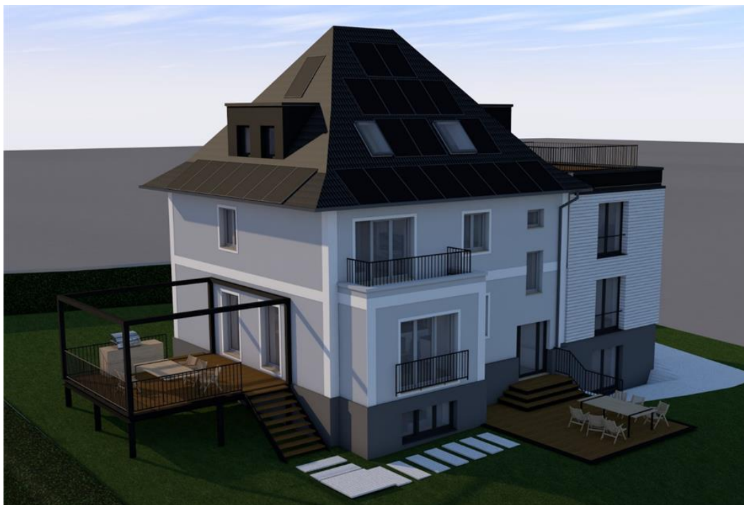
Abbildung 1: Gartenseitige Ansicht „neu“ von Südosten – mit PV auf Dachflächen. Hinzu kommt PV auf Pergola und Garage.
