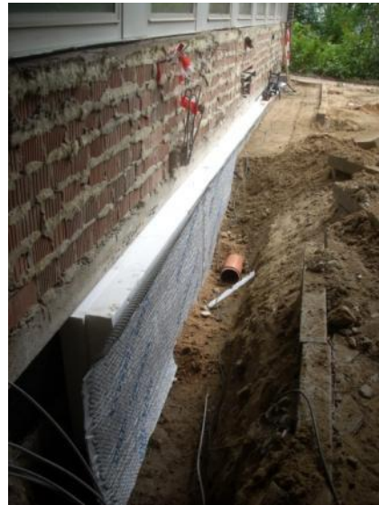
Abbildung 7: Randdämmung
