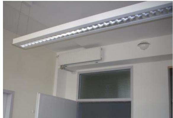
Abbildung 8: Hocheffiziente Luft-, Licht- und Wärmeversorgung mit Miniheizkörpern über Türen
